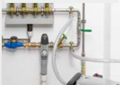
Výplach rozvodů pitné vody
