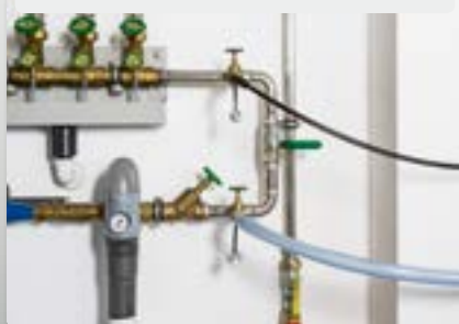
Tlaková zkouška vodou
