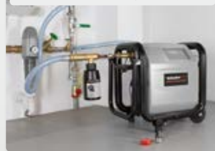
Dezinfekce rozvodů pitné vody
