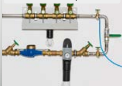
Tlaková zkouška stlačeným vzduchem
